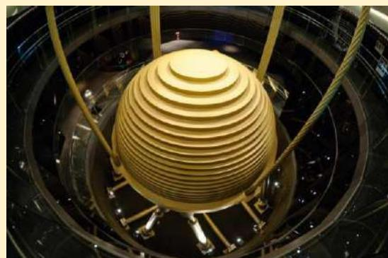
prigušivač protuteže koja teži više od 600 tona – nadoknađuje nestabilnost tijekom potresa i tajfuna
